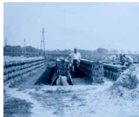
Száradásra kész és épülő mórteglá falak
